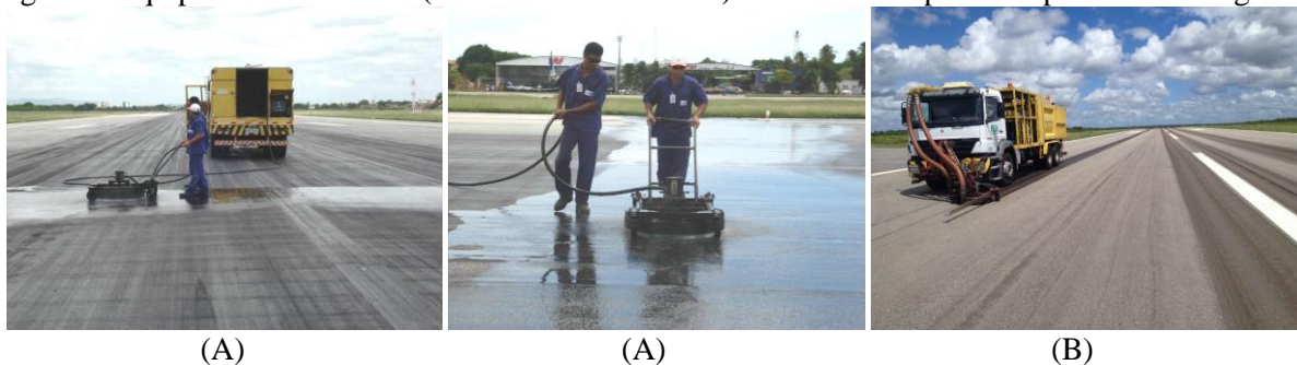
Figura 2. Equipamentos/técnicas (anterior - A e atual - B) utilizados nas pistas de pouso e decolagem.
