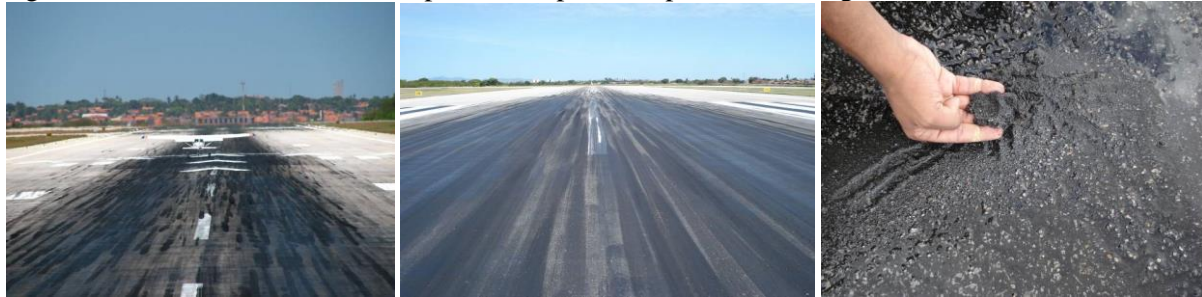
Figura 1. Borracha acumulada na superfície de pistas de pouso e decolagem.
