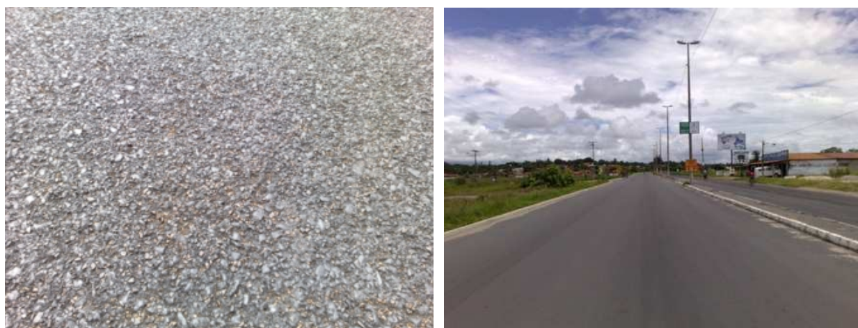
Figura 3. Revestimentos em TSD e CBUQ, respectivamente, utilizados nas rodovias analisadas.
