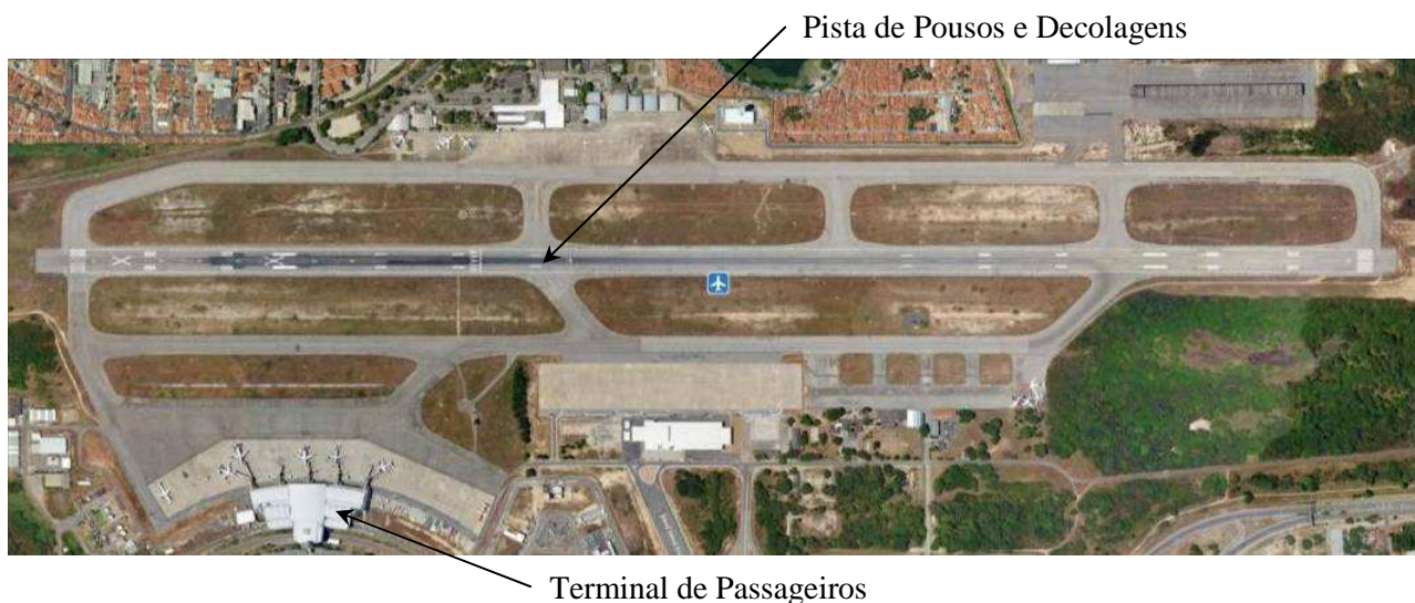
Figura 5. Foto aérea do complexo de pistas do Aeroporto Internacional de Fortaleza
