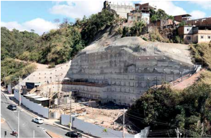
Figura 2 – Contenção em cortina atirantada
