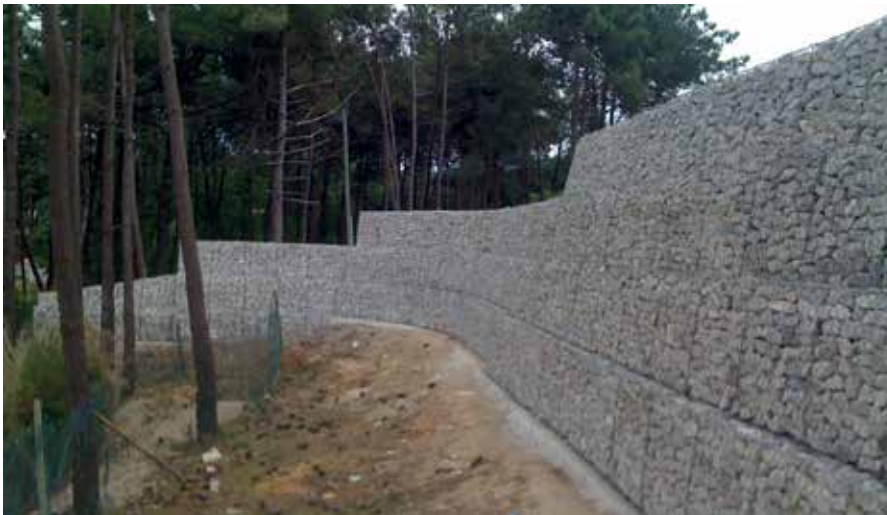
Figura 3 – Contenção em gabião
