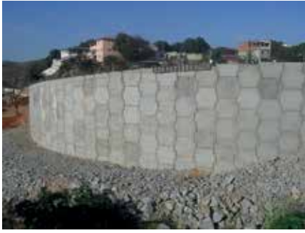
Figura 5 – Contenção em terra armada
