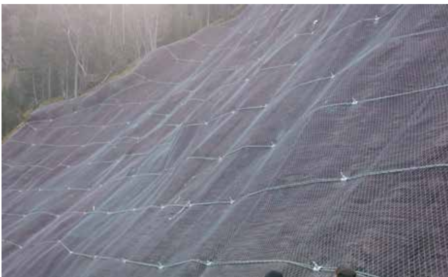
Figura 4 – Contenção em tela de alta resistência
