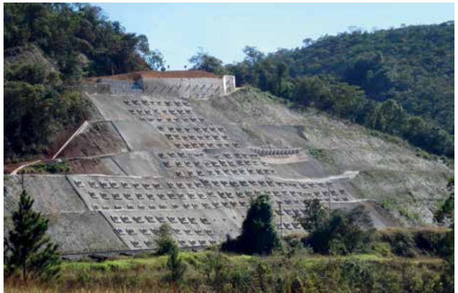
Figura 1 – Contenção em solo grampeado
