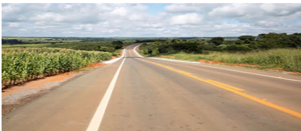
Figura 1. Foto da rodovia DF-355 implantada.
