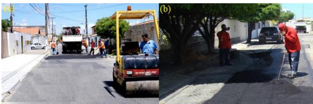
Figura 9. (a) - Recuperação de remendos (b) - Recuperação de panelas
