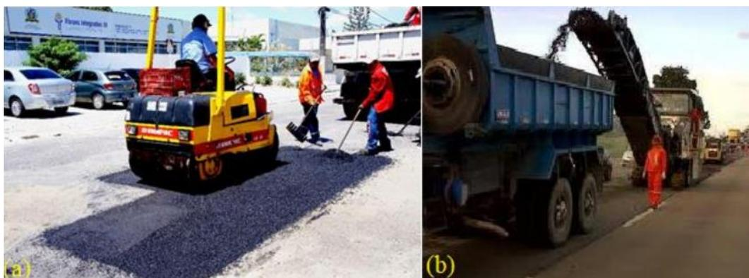
Figura 8. (a) - Processo de recapeamento (b) – Processo de fresagem
