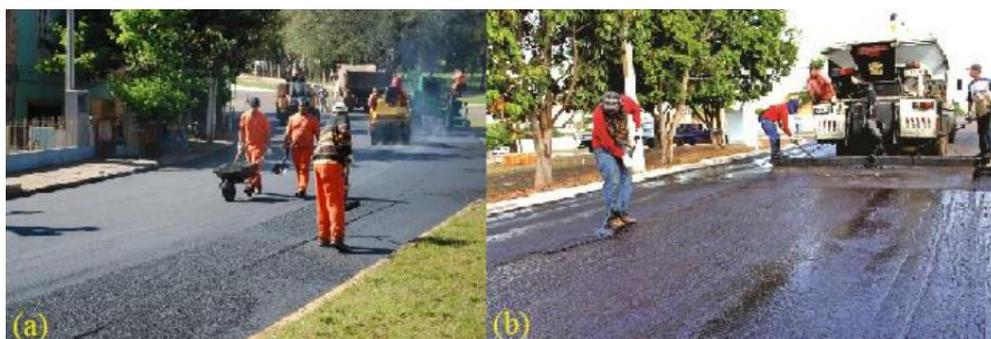
Figura 7. (a) - Aplicação de capa selante (b) - Utilização de lama asfáltica em via pública
