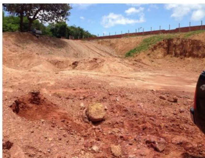
Figura 2: Escavação do local da amostra
