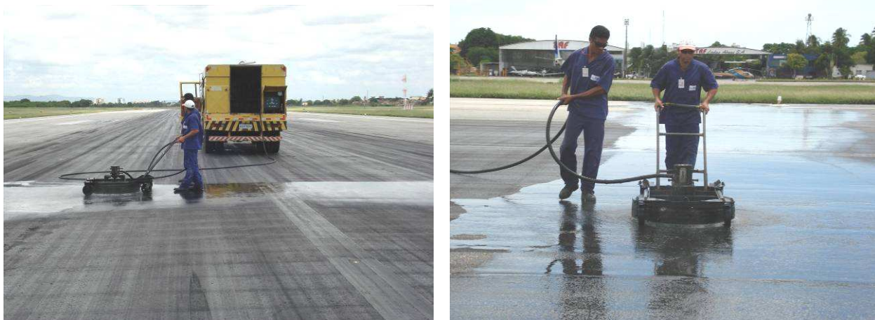
Figura 5. Serviços de remoção de borracha com jato de água de alta pressão em pavimento flexível aeroportuário
