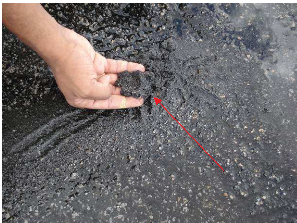
Figura 6. Resíduos da borracha retirada do pavimento
