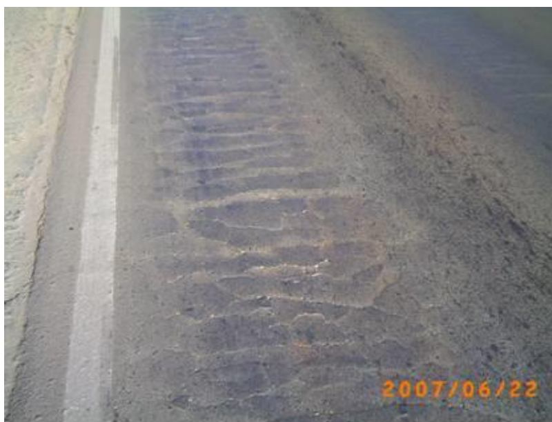
Figura 5: Segmento recém restaurado através de reciclagem da Base com trincamento.
