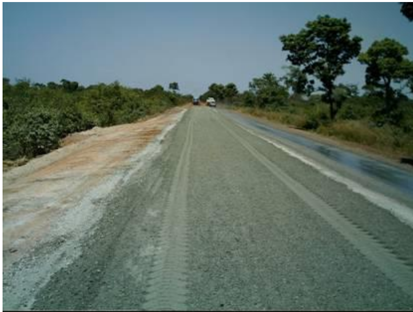
Figura 3: Lançamento de brita graduada sobre pavimento antigo.
