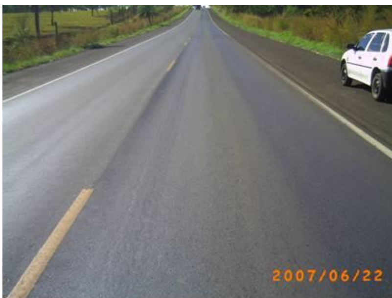
Figura 6: Trecho reciclado com ocorrência de deformação permanente
