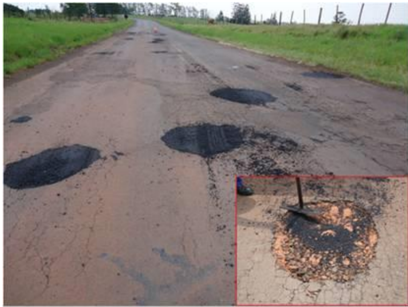
Figura 10: Operações tapa buraco emergenciais.
