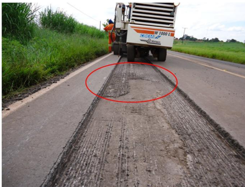
Figura 9: Execução de fresagem ineficiente.
