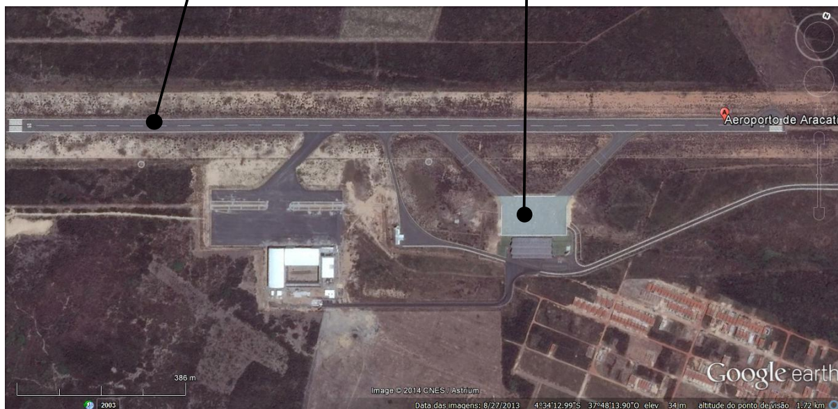
Figura 4. Imagem aérea do aeroporto de Aracati (Fonte: Google Earth, 2014)
