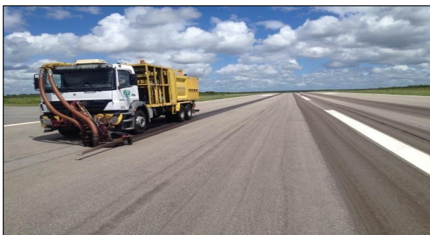
Figura 3. Retexturização da pista do Aeroporto Dragão do Mar (INFRAERO, 2014).
