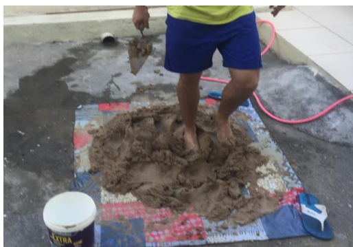
Figura 2. Preparação do solo para fabricação dos tijolos de adobe.
