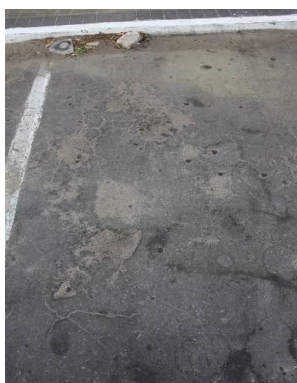
Figura 2 : Trinca interligada
