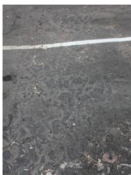
Figura 4 : Desgaste
