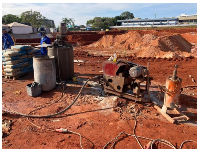
Figura 5 – Conjunto bomba de argamassa de cimento e misturador
