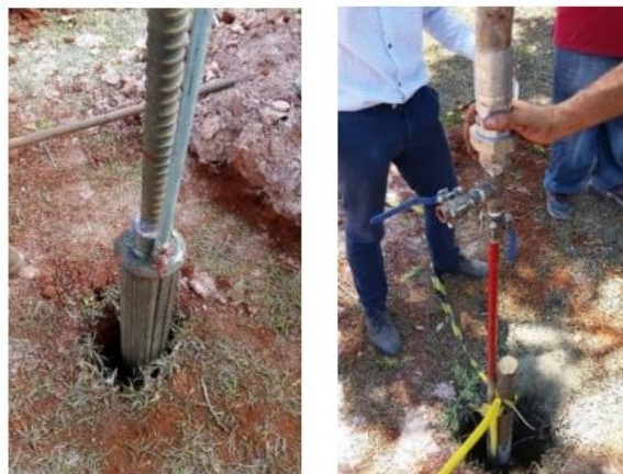
Figura 4 – Instalação da tecnologia EB em estaca escavada convencional
