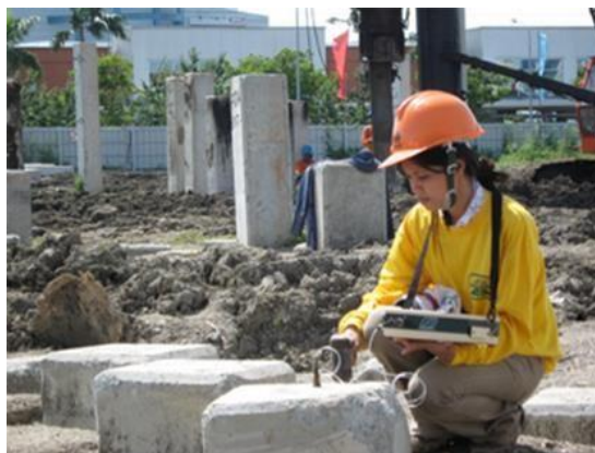
Figura 1. Execução do PIT
