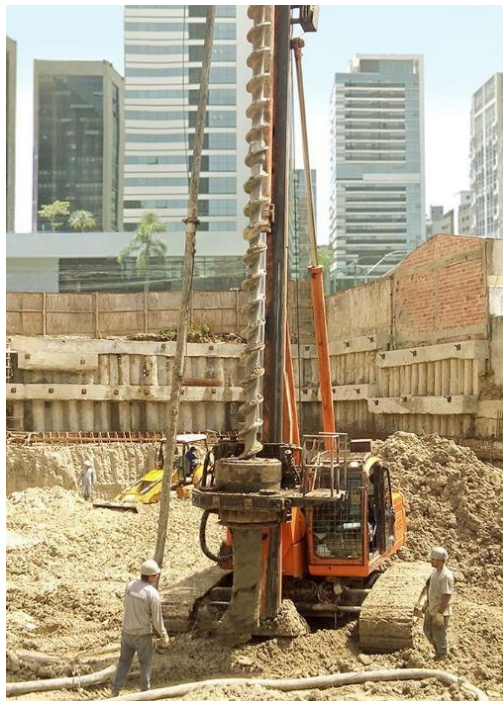
Figura 5. Equipamento utilizado na execução das estacas.
