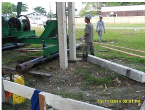
Figura 6. Cravação das estacas.
