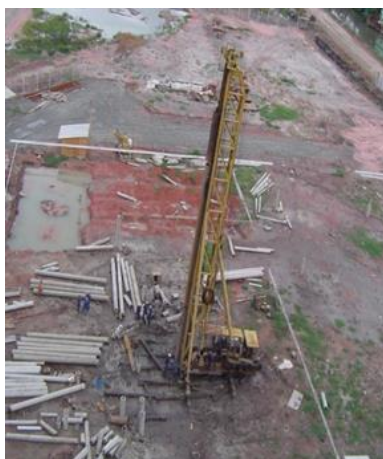
Figura 3. Bate-estacas Franki adaptado com pilão e piteira para execução do pré-furo.
